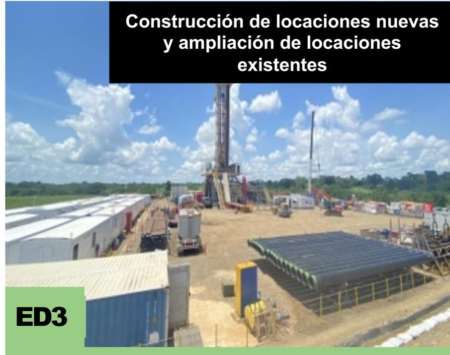
Construcción de **hasta veinte (20) locaciones multipozo de seis (6) ha. cada una**, desde las cuales se perforarán hasta cinco (5) **pozos por locación. Ampliación de las locaciones existentes (Búho 1x, Pilón 1, Pilón 2) y proyectada (Pilón 3)**, para que ocupen un área de máximo **6 ha. cada una y para perforar cuatro (4) pozos adicionales en cada una de ellas.**
