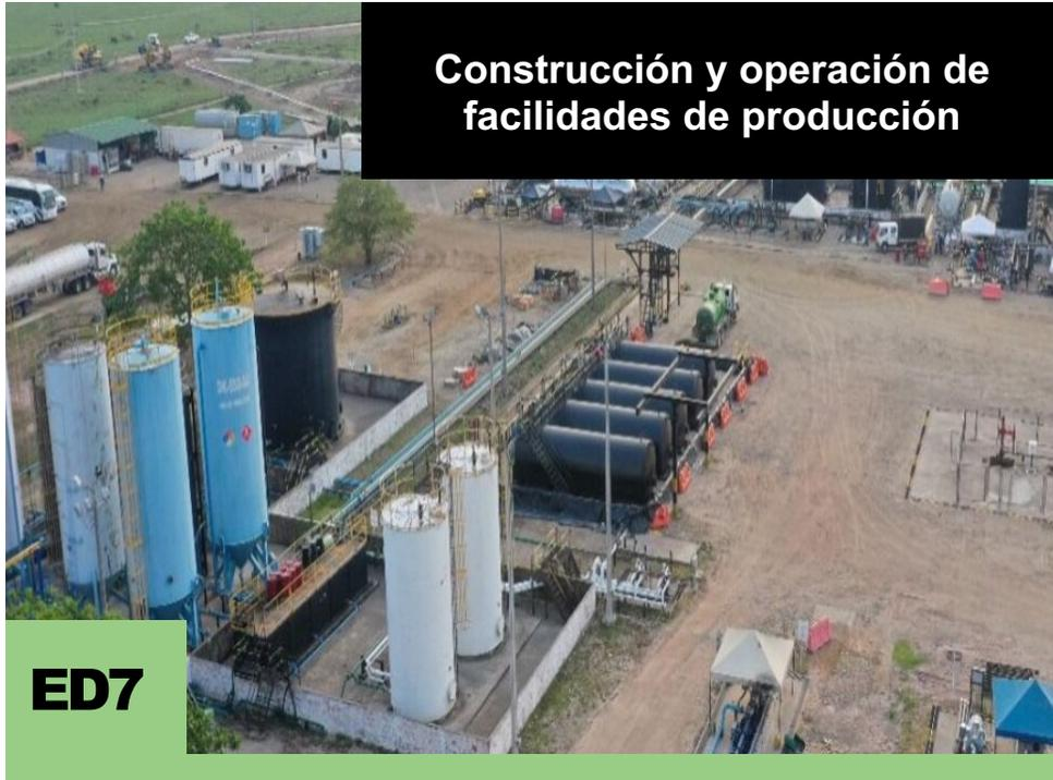
Construcción de **Facilidades Tempranas de Producción-FTP** a ubicar dentro de las locaciones. Construcción de **hasta tres (3) Facilidades Centrales de Producción - CPF con un área máxima de 15 ha.** cada una, con: zonas de operaciones, campamentos, helipuerto, torres de comunicaciones y todas aquellas áreas, equipos e infraestructura para su normal desarrollo.
