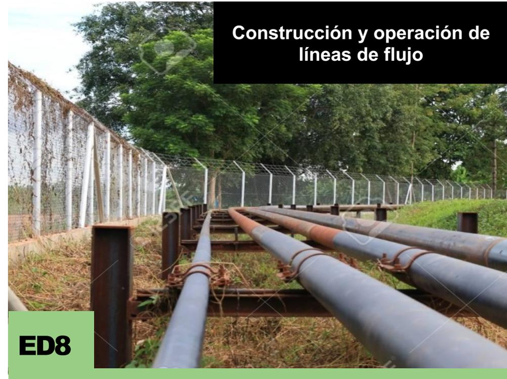
**Hasta 240 km de líneas de flujo** para interconexión del campo, con diámetros entre 2" a 6". Hasta dos (2) líneas de flujo con diámetros entre 6" a 8", para conexión de la producción total del AD SN 26 al Sistema Nacional de Transporte (SNT). **Derechos de vía de hasta 20 m. a campo traviesa o 15 m. paralelos a vías de acceso.**
